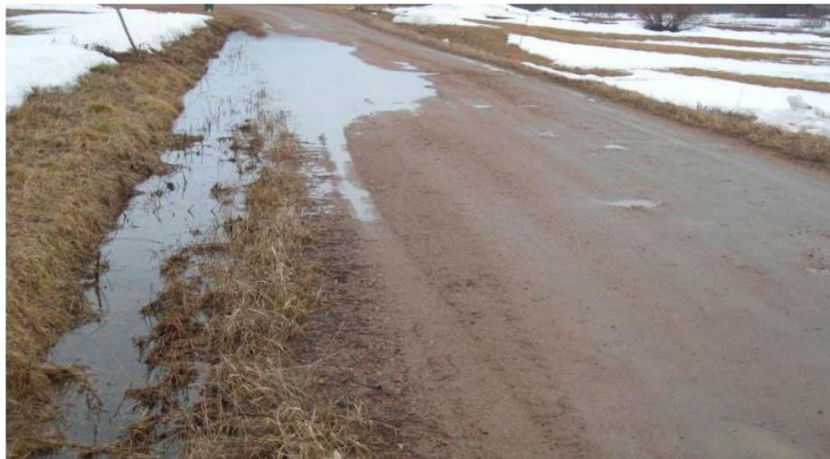
**Дорожная конструкция плохо защищена от воздействия воды и ускоренно разрушается.**
